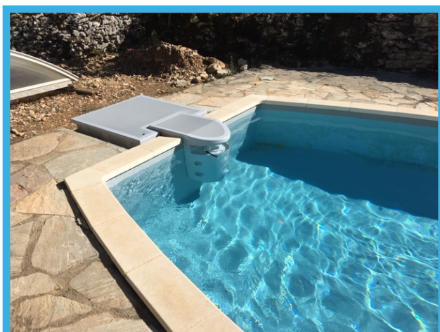
Rénovation d'un bassin ovoïde avec MCC14
